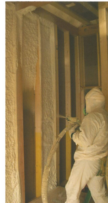
□ フォームライトSLの吹き付け施工風景
