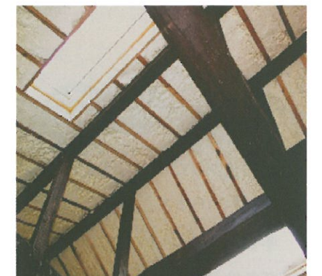
□ 細部まで隙間なく気密化
